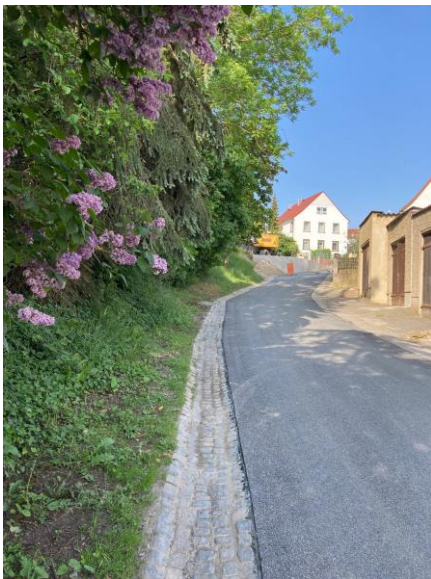
Abb. 6 und 7: Erneuerung Asphaltdecke in der Badstraße im Bereich des Drosselbauwerkes des AZV
