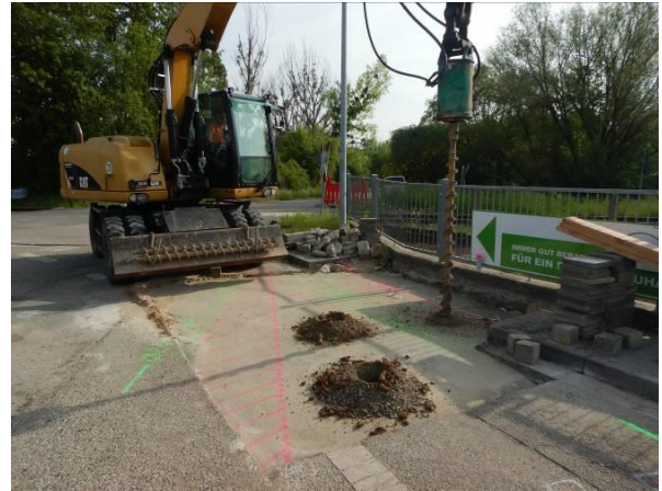
Abb. 5: Bohrungen zur Kampfmittelfreigabe
