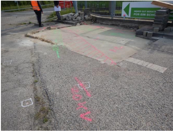
Abb. 4: mit Flüssigboden versiegelte Oberfläche
