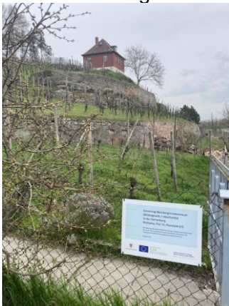
Abb. 3: Sanierung Natursteinmauern Klingerweinberg
