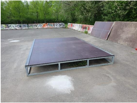
Abb. 8 neues Podest Skateranlage
