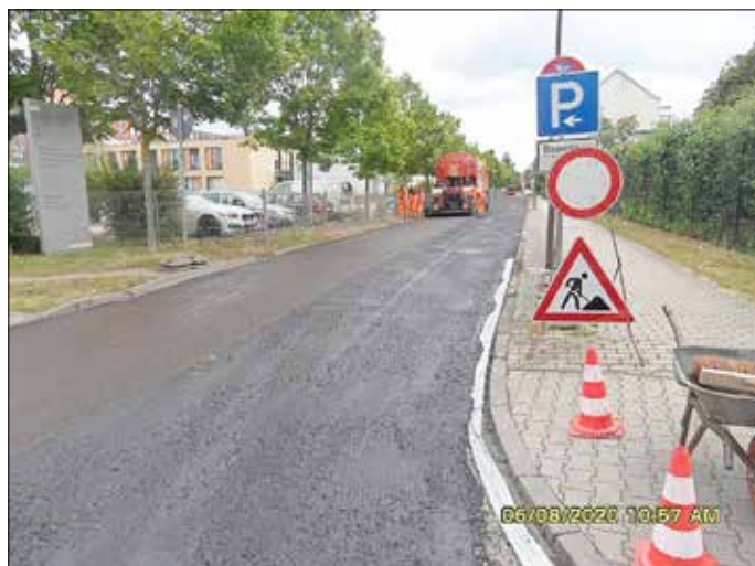
Die neue Fahrbahndecke in der Professor-Röntgen-Straße
